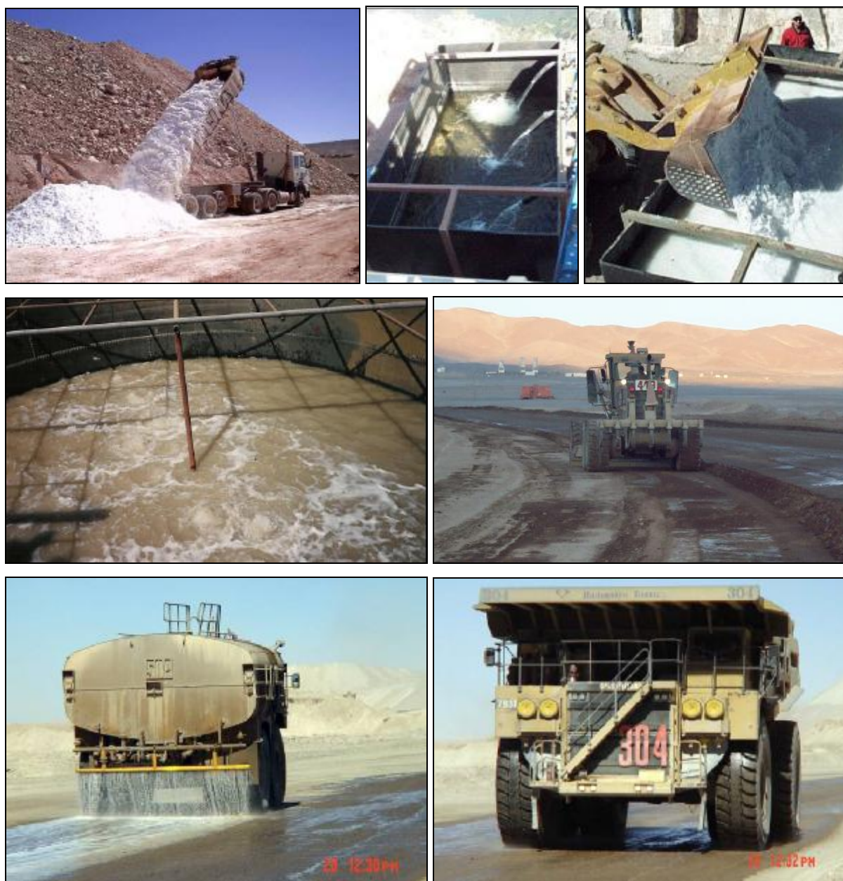
Figura 5. Ejecución de tratamiento supresor de polvo con bischofita (Halles et al., 2005)
