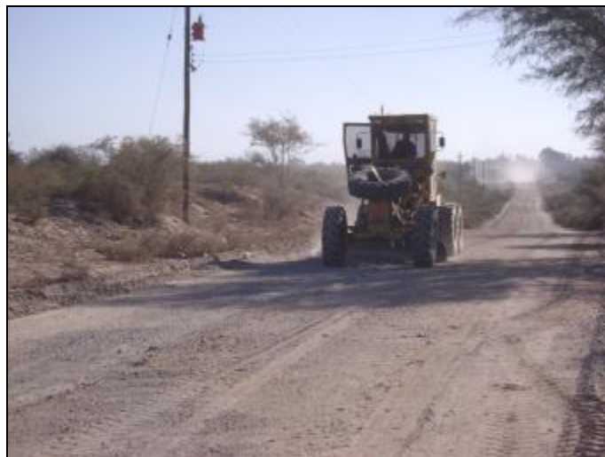
Figura 11. Actividades de reacondicionamiento preliminar, acceso sur a Huaco
