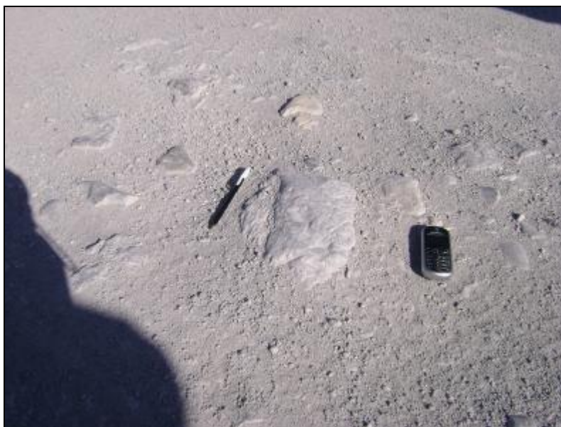
Figura 8. Material pétreo superficial del tramo no pavimentado en la R.P. N° 351
