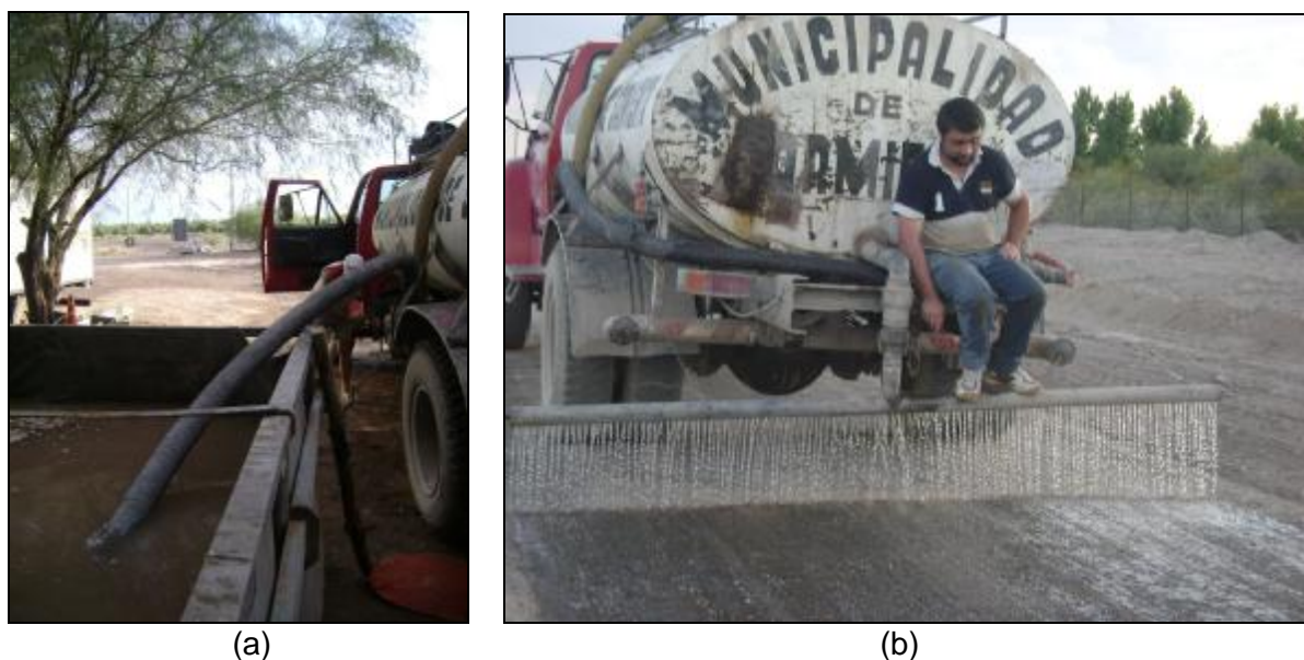
Figura 17. Cargado de solución de bischofita en el camión regador (17-a) y aplicación de riego de la solución sobre el segundo subtramo de la R.P. N° 318 (17-b)
