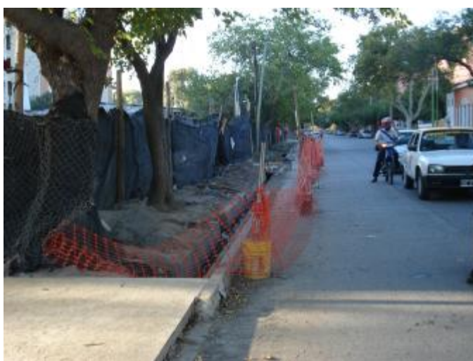
Foto3: Vereda provisoria sobre Av. Las Heras
