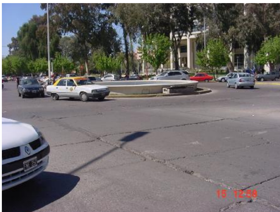
Foto4: Falta de mantenimiento de la demarcación.
