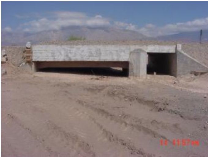
Fotografía N° 19 Vista aguas abajo. Progr. 3550.95 km.
