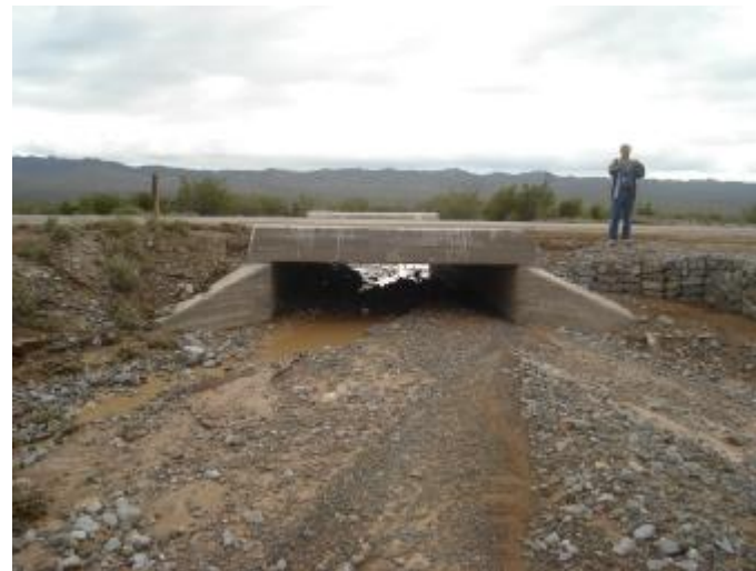
Fotografía N° 6. Vista aguas arriba. Progr. 3522.38 km.
