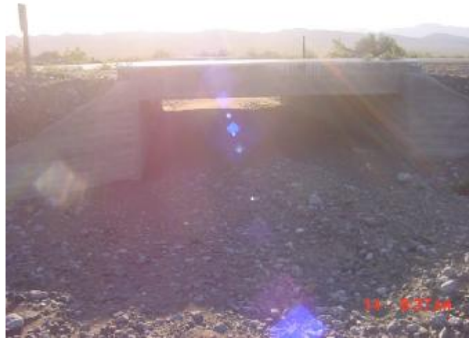
Fotografía N° 3. Vista aguas arriba. Progr. 3520.68 km.
