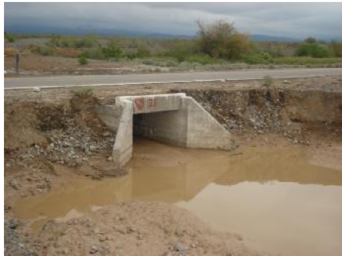
Fotografía N° 4. Vista aguas abajo. Progr. 3521.18 km.
