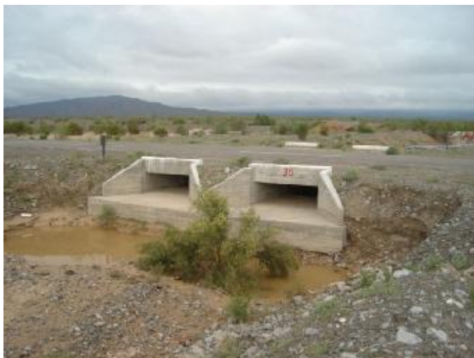
Fotografía N° 9. Vista aguas abajo. Progr. 3524.25 km.
