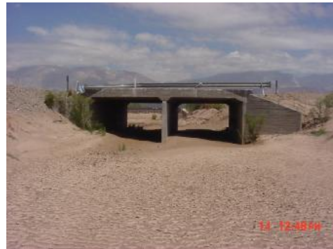
Fotografía N° 20 Vista aguas abajo. Progr. 3552.58 km.
