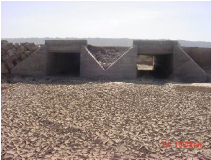
Fotografía N° 13. Vista aguas arriba. Progr. 3527.58 km.
