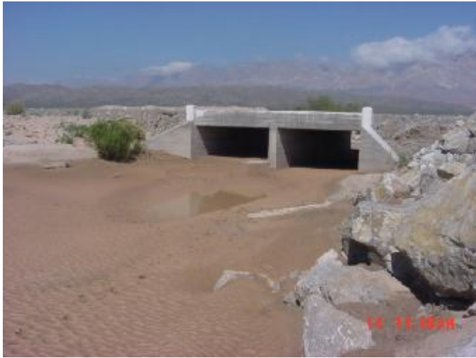
Fotografía N° 17. Vista aguas abajo. Progr. 3546.33 km.
