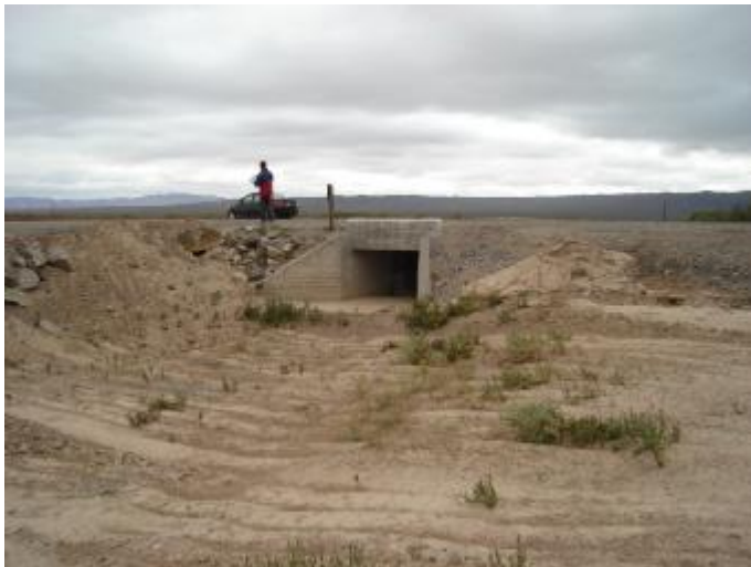
Fotografía N° 15. Vista aguas arriba. Progr. 3537.33 km.
