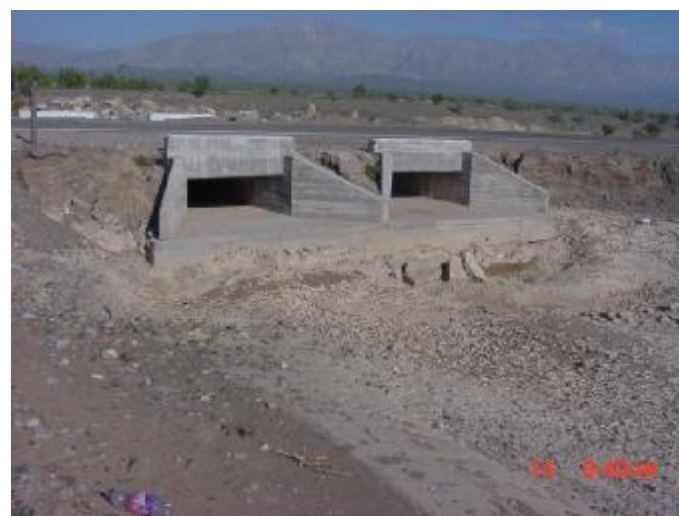
Fotografía N° 10. Vista aguas abajo. Progr. 3525.23 km.
