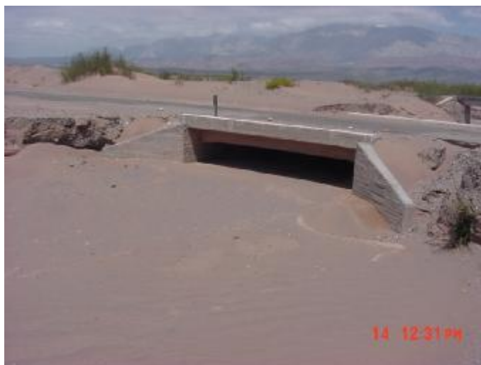
Fotografía N° 21. Vista aguas abajo. Progr. 3554.47 km.
