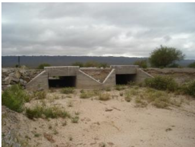
Fotografía N° 11. Vista aguas arriba. Progr. 3526.18 km.
