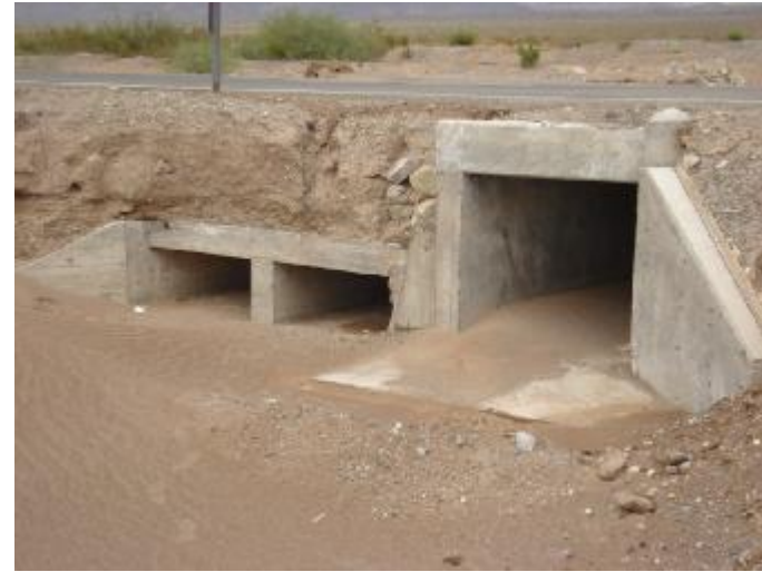
Fotografía N° 18. Vista aguas abajo. Progr. 3548.78 km
