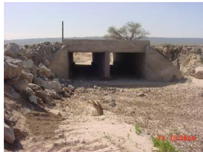
Fotografía N° 16. Vista aguas arriba. Progr. 3537.98 km.
