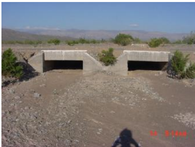
Fotografía N° 5. Vista aguas abajo. Progr. 3521.73 km.
