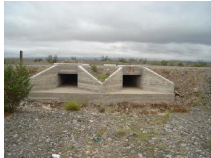
Fotografía N° 14. Vista aguas abajo. Progr. 3528.61 km.
