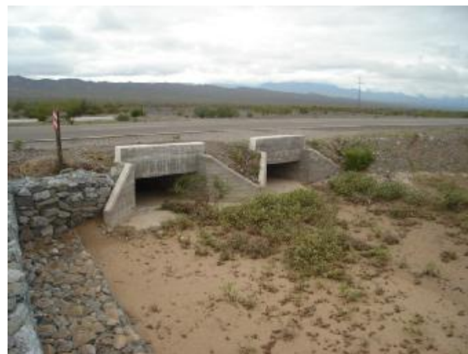
Fotografía N° 8. Vista Aguas arriba. Progr. 3523.58 km.
