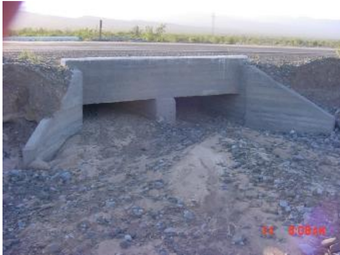
Fotografía N° 1. Vista aguas arriba. Progr. 3518.68 km.
