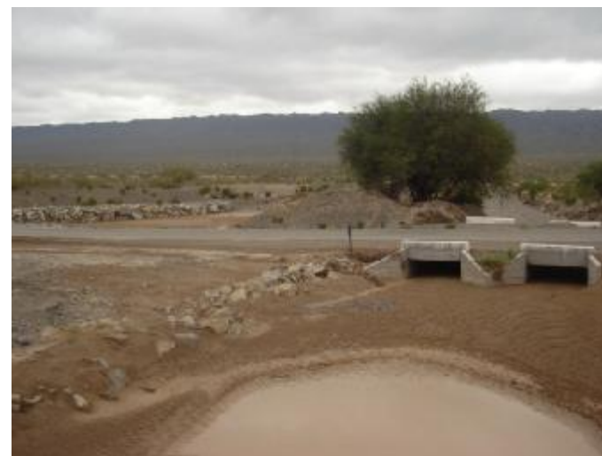
Fotografía N° 12. Vista aguas arriba. Progr. 3527.13 km.
