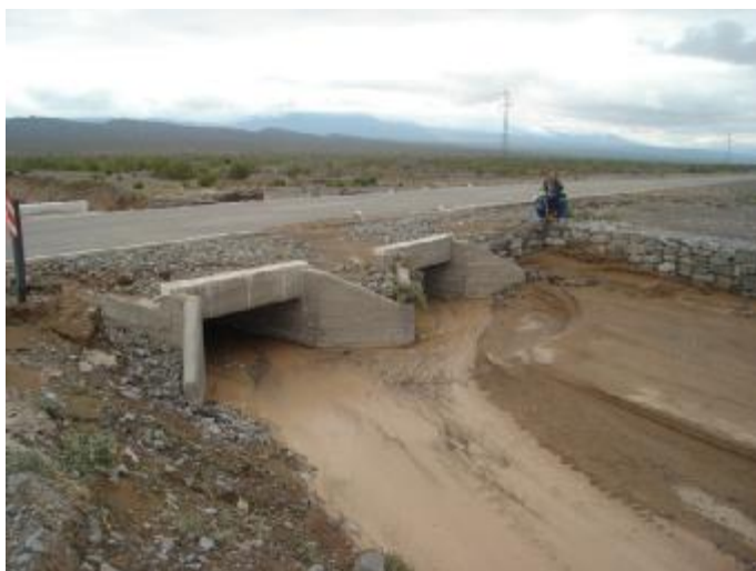
Fotografía N° 7. Vista aguas arriba. Progr. 3522.88 km.
